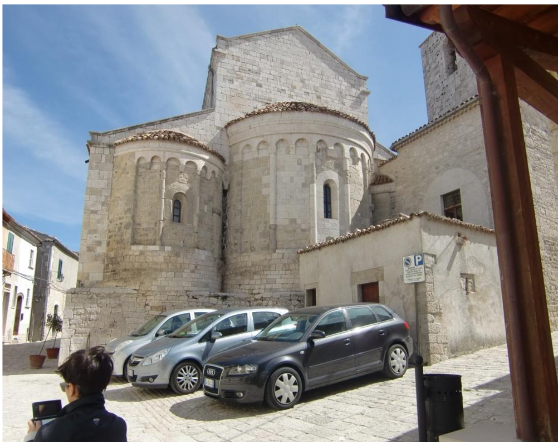
Fig.79. Prospetto ovest della Chiesa
