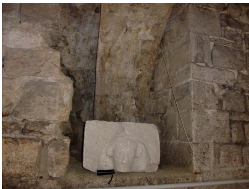
Fig. 82. Particolare di interruzione delle arcate della cripta dovuta alla successiva costruzione del muro absidale della sovrastante chiesa
