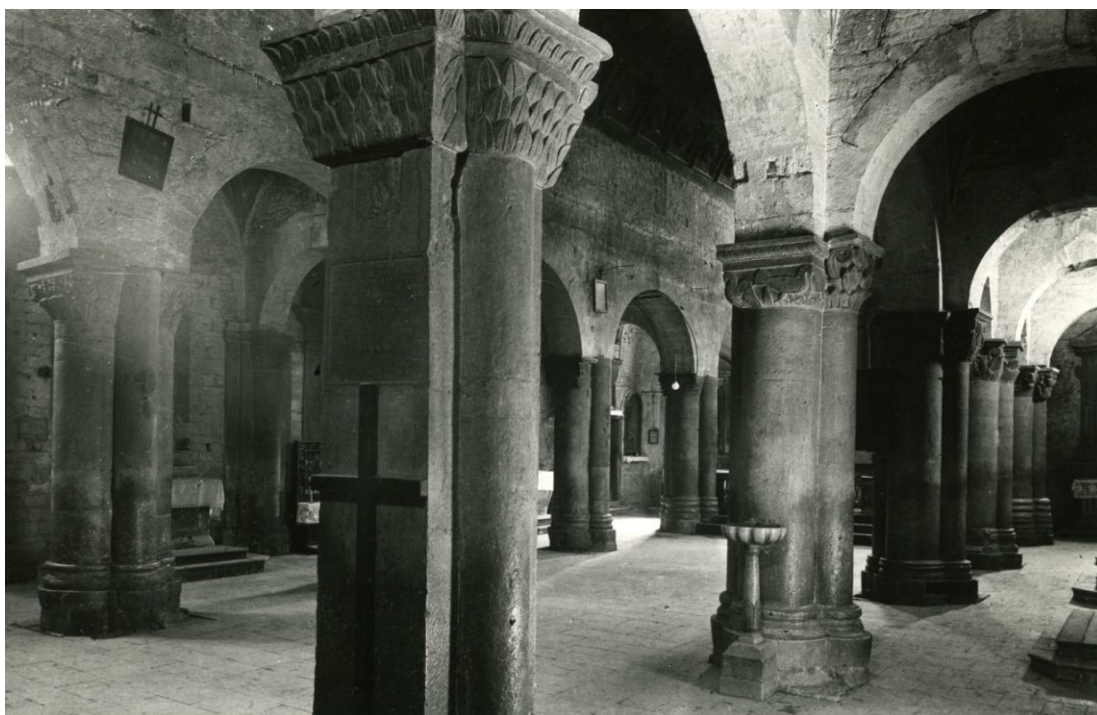
Foto interne della Chiesa in cui risulta evidente la copertura a botte della navata centrale
