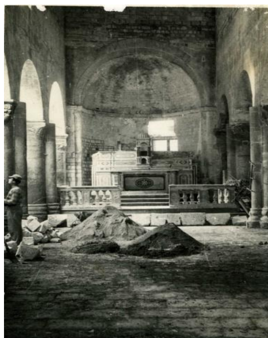
Passati lavori di restauro della Chiesa
